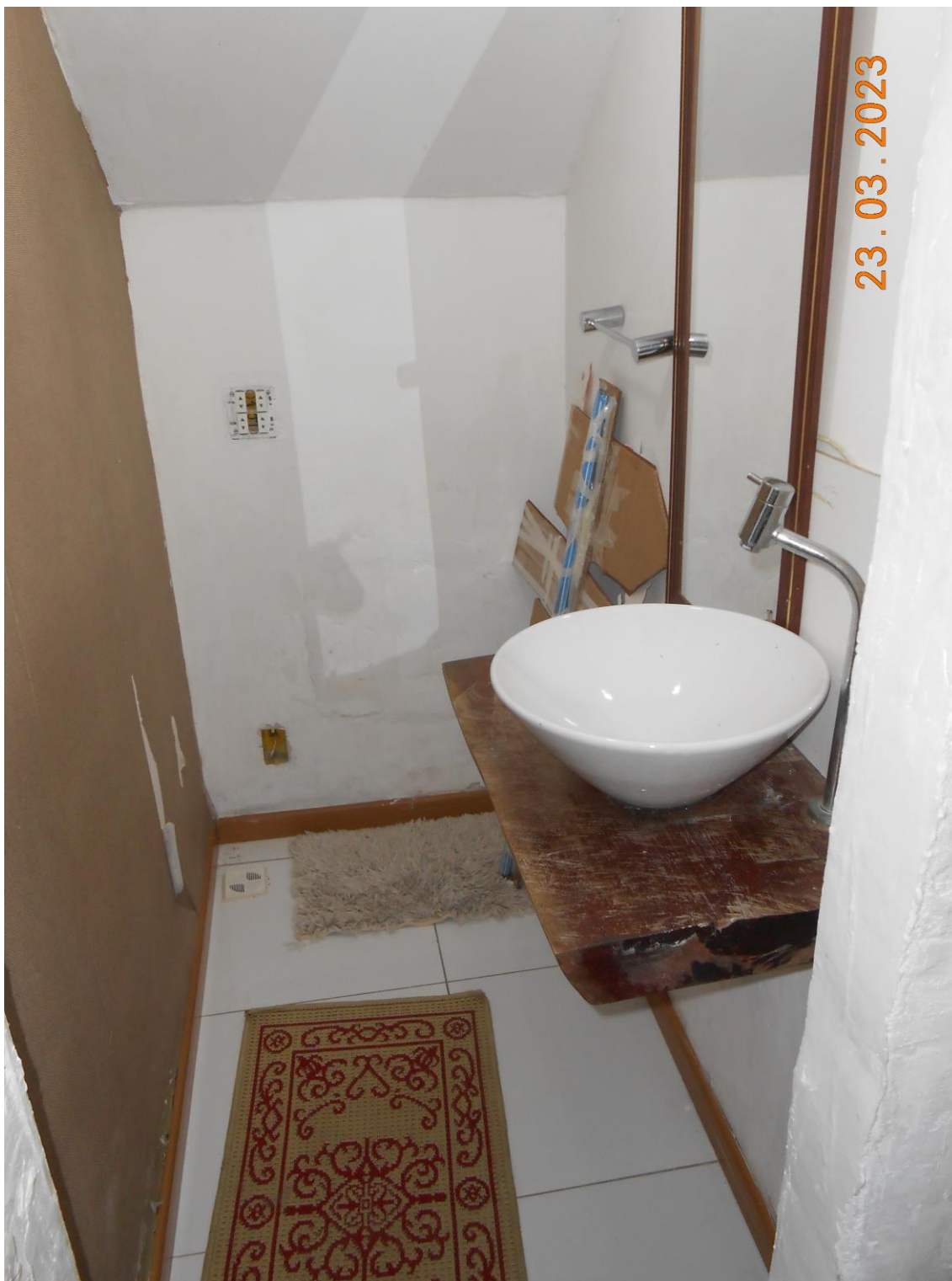
FOTO 8 – LAVABO SOB ESCADA DE ACESSO AO 1º PVT.
