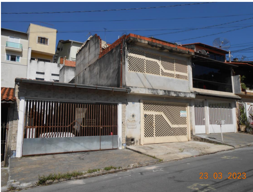
FOTO 3 – OUTRA VISTA DO IMÓVEL AVALIANDO.
