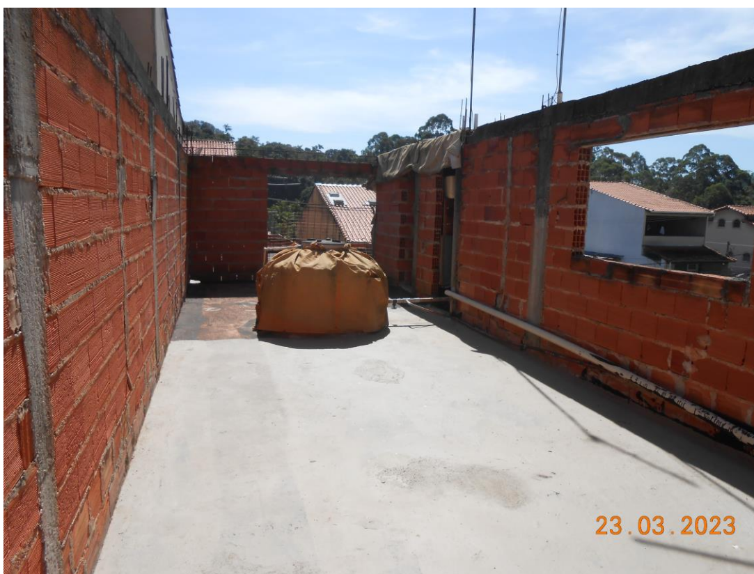
FOTO 4 – OBRAS PARALISADAS SOBRE LAJE SUPERIOR.
