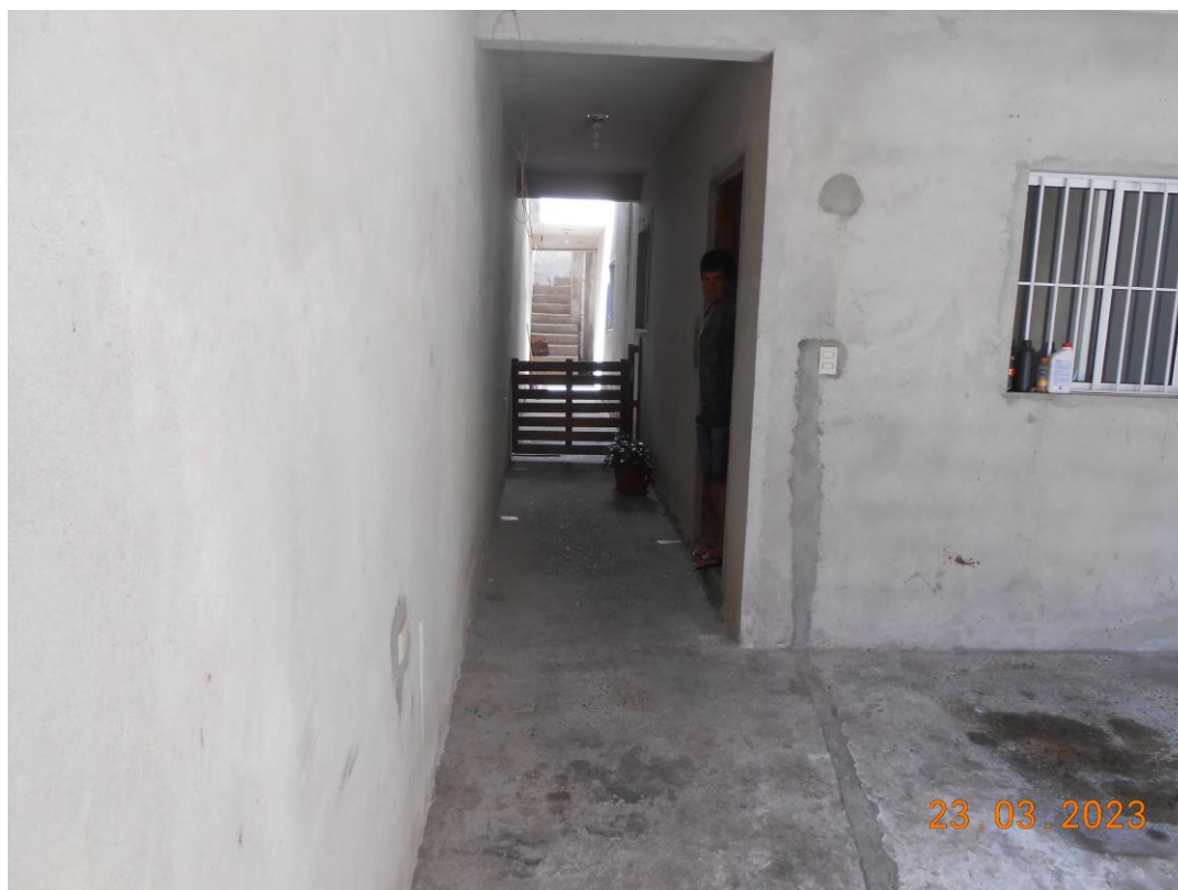
FOTO 6 – CORREDOR LATERAL EXTERNO.
