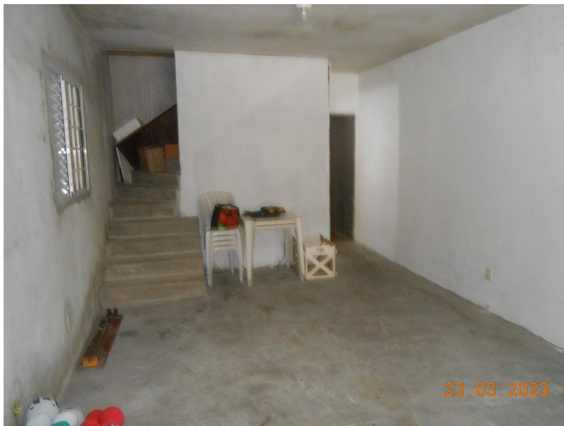
FOTO 7 – SALA, PAVIMENTO TÉRREO.
