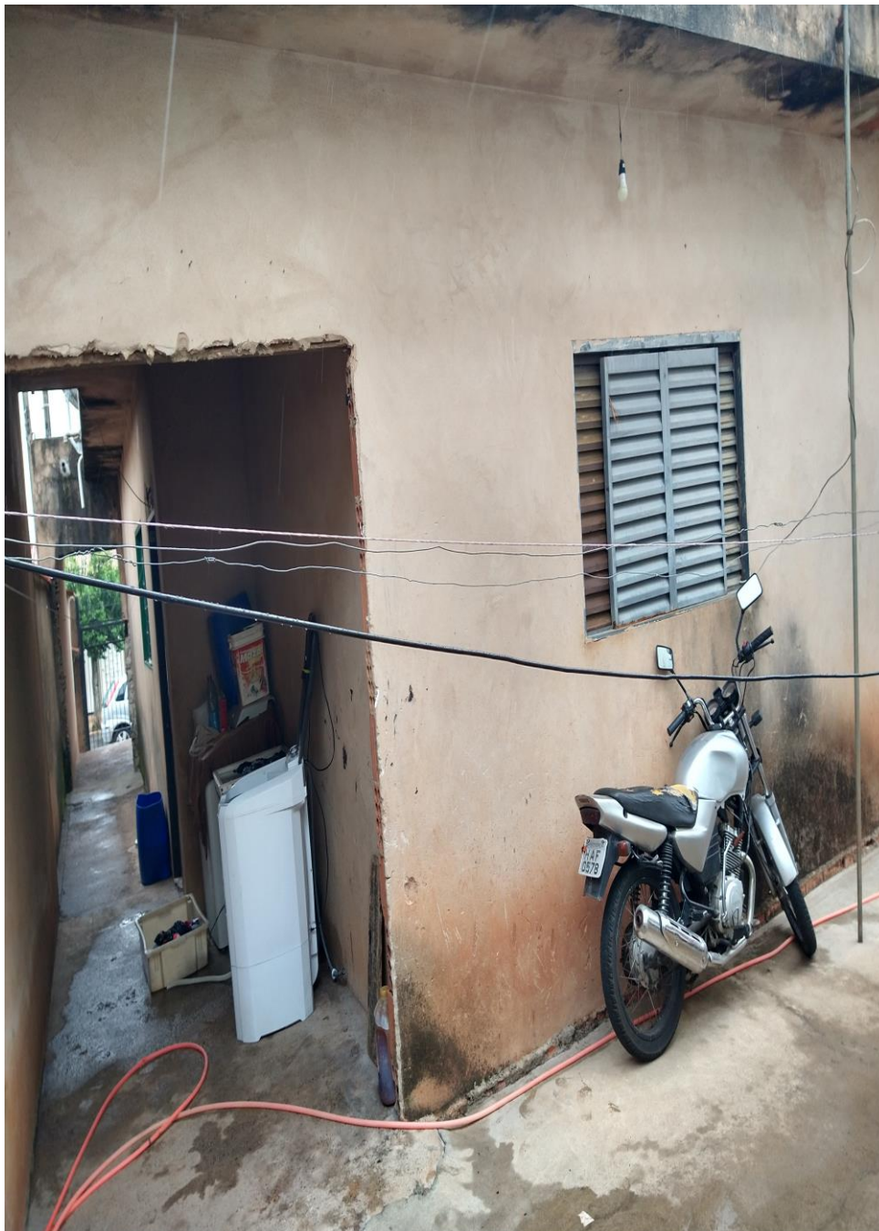
FOTO nº. 13 - RESIDÊNCIA – FUNDOS DETALHE: Vista externa – piso cimentado.
