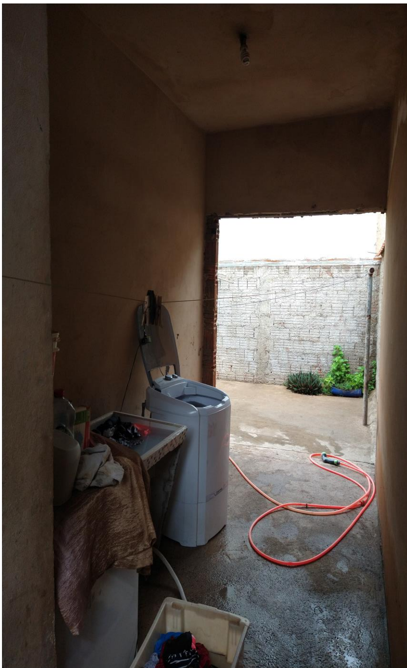
FOTO nº. 12 - RESIDÊNCIA – LAVANDERIA DETALHE: Materiais de Acabamento.
