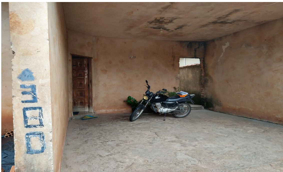
FOTO nº. 4 - RESIDÊNCIA - GARAGEM DETALHE: Acabamentos.
