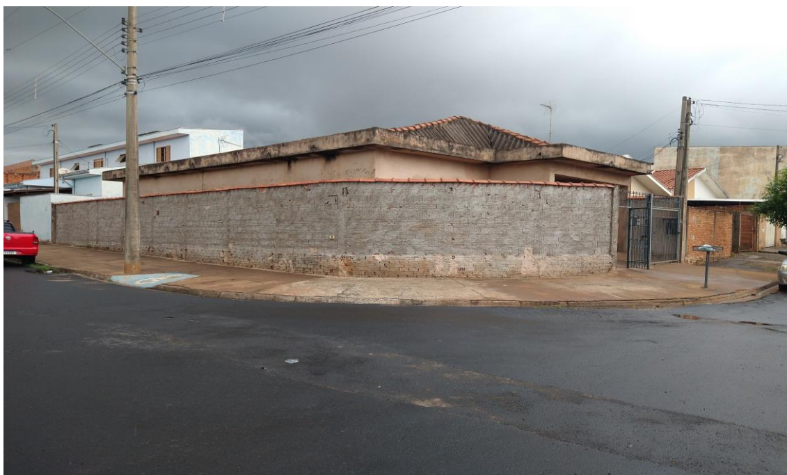
FOTO nº. 2 - FACHADA - RESIDÊNCIA DETALHE: Vista: Rua Benedito Pinheiro. Muro de divisa.
