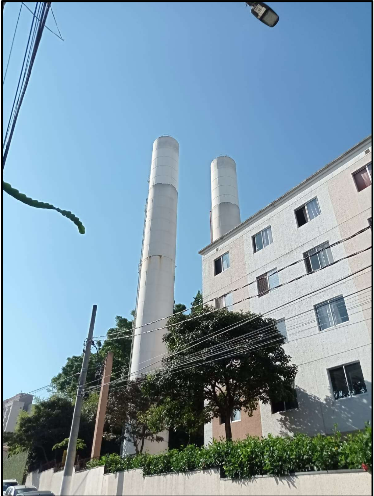
Edifício e caixas de água do Residencial Chácara Campo Limpo
