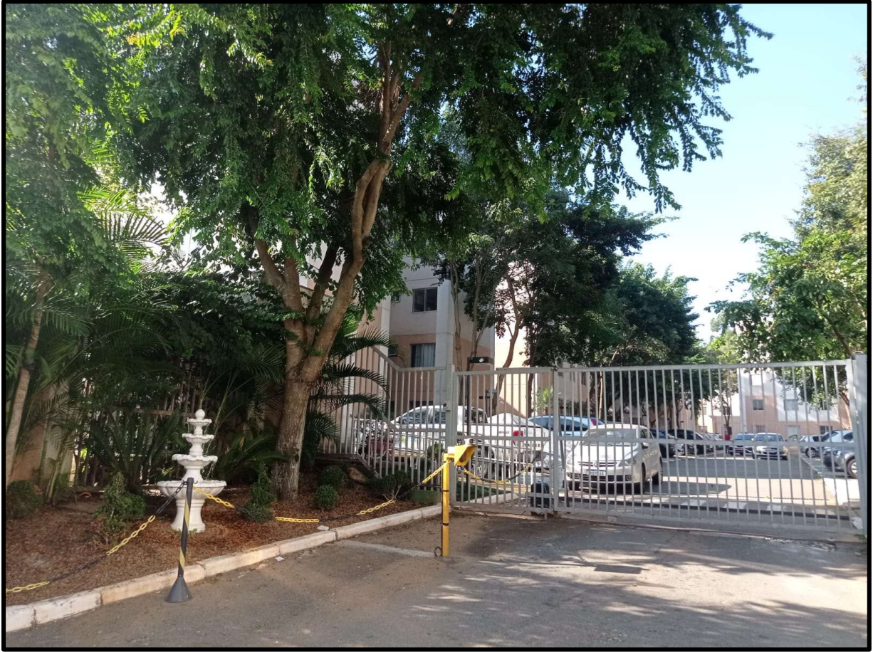
Entrada e saída de veículos do Residencial Chácara Campo Limpo
