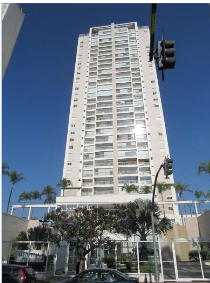
FACHADA DO IMÓVEL AVALIANDO (6).
