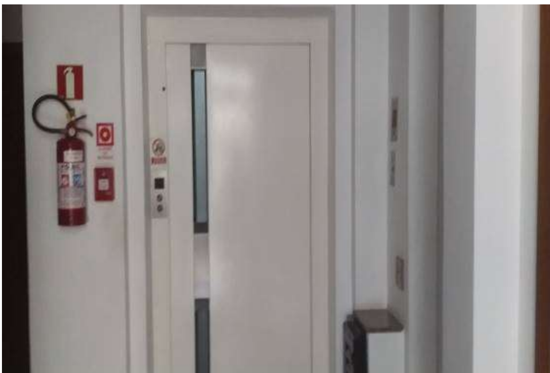
FOTO N° 09 – Vista do elevador de acesso aos andares.
