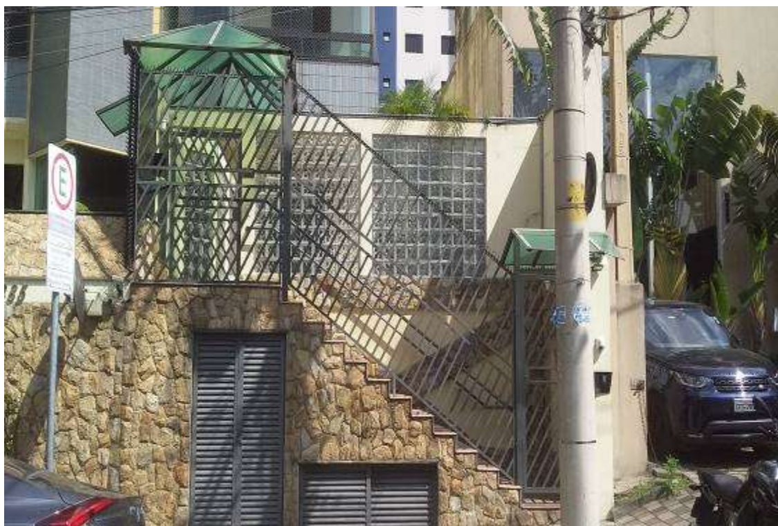
FOTO Nº 05 - Vista do portão de acesso dos condôminos e visitantes.
