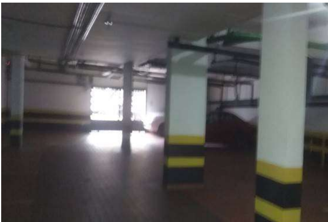
FOTO Nº 12 – Vista da garagem.
