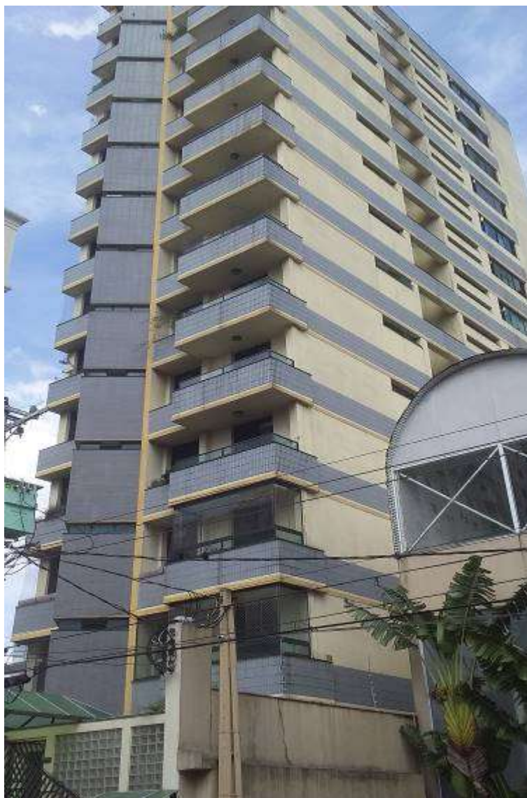
FOTO Nº 03 – Vista do Edifício da Vinci, onde se localiza o apartamento de nº 11 no 1º andar, objeto da ação.
