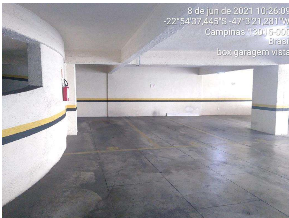
FOTO 24 – VISTA GERAL GARAGENS
